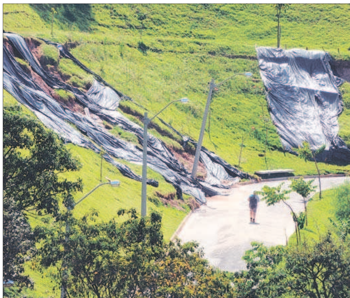
Lonas colocadas para conter novos deslizamentos após ocorrências registradas no início do ano no parque
