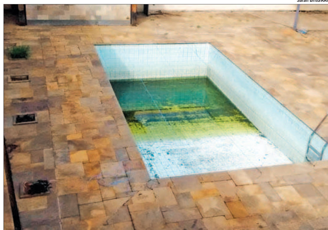
Piscina em casa no Taquaral alvo de preocupação de vizinhos, que temem possíveis focos do mosquito
