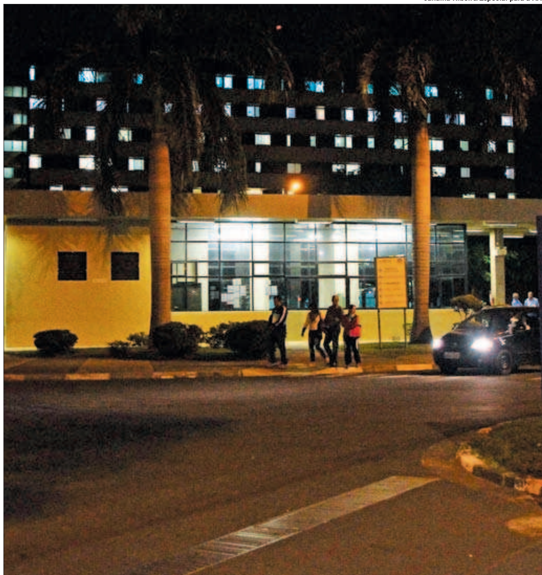
Movimentação em entrada do Hospital Estadual de Sumaré: negociação para evitar cortes e demissões
