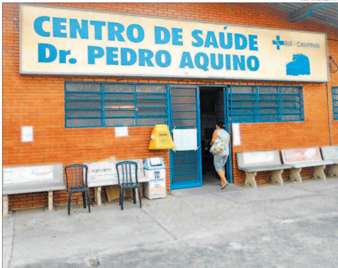
Centro de Saúde do Balão do Laranja foi fechado ontem por uma semana para obras de emergência
