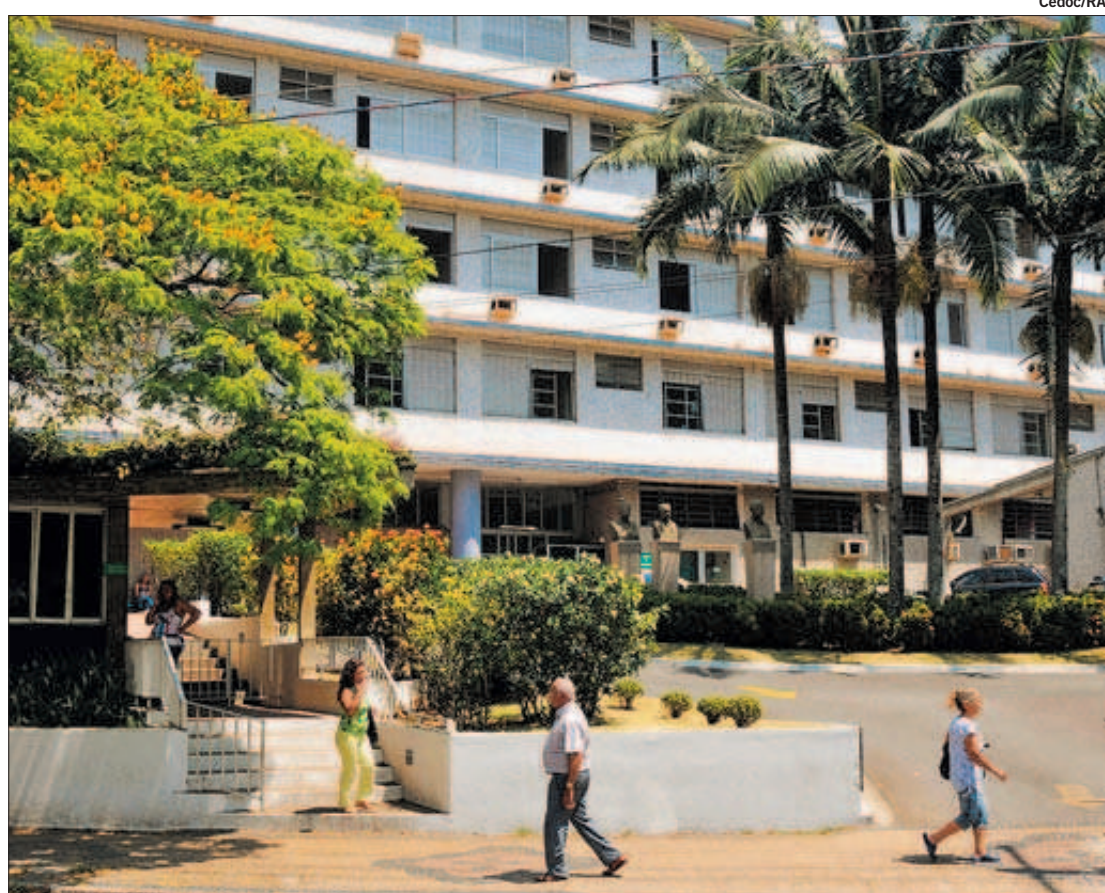
Maternidade estuda uso de poço desativado para reforçar reservas: situação pode ficar crítica depois de abril
