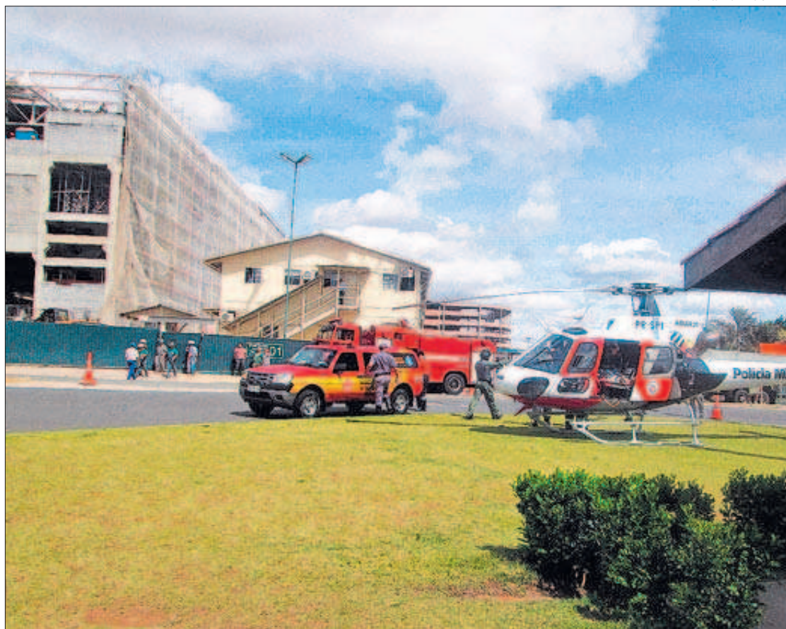
HELICÓPTERO ÁGUIA DA PM foi usado no resgate do motorista Dirceu Rodrigues Cordeiro, que ficou ferido após o caminhão que dirigia tombar em uma rampa no subsolo da obra de ampliação do shopping
