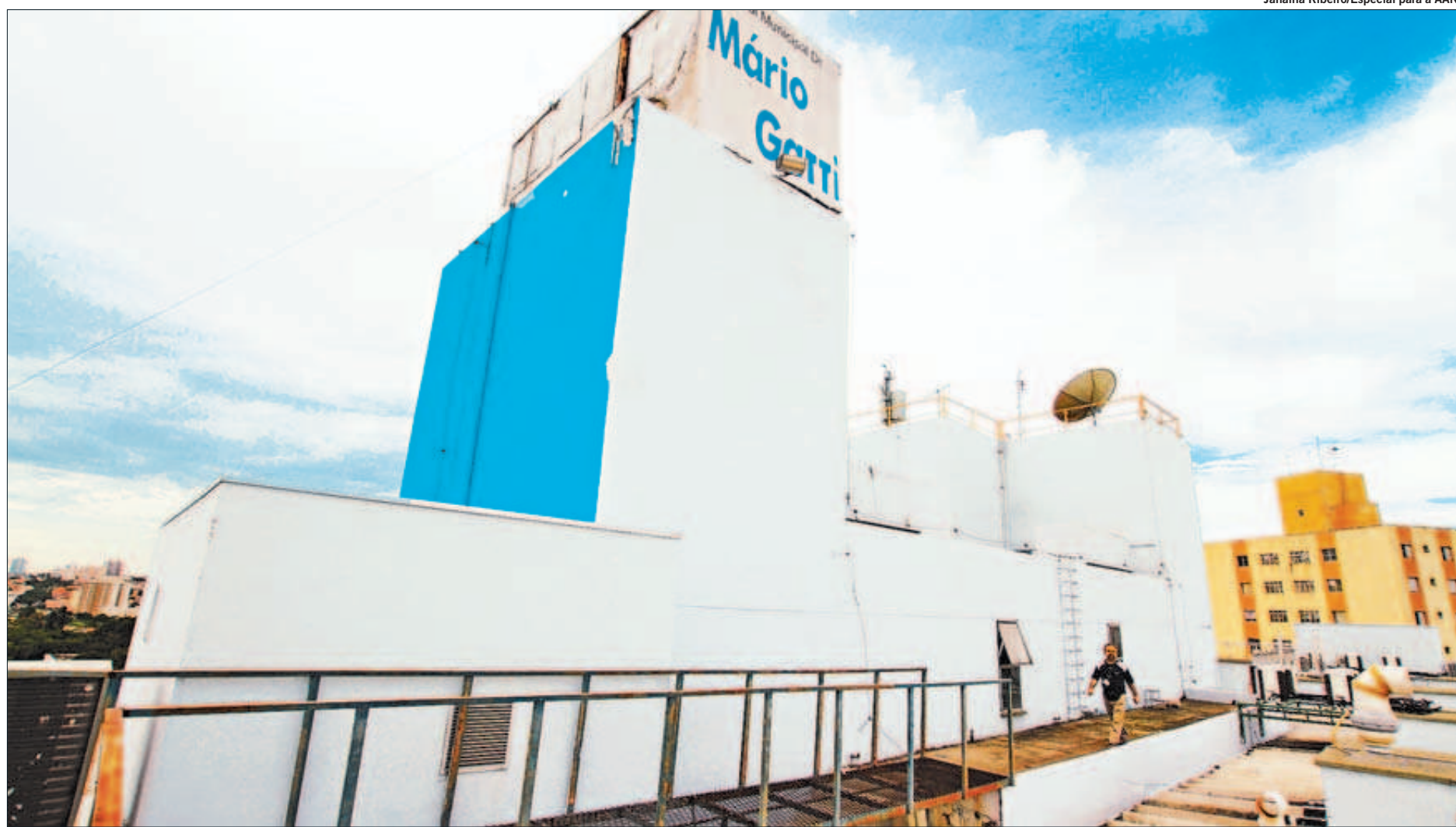
Hospital Mário Gatti tem sete caixas de água com capacidade de 280 mil litros, que garantem dois dias de reserva: Sanasa alerta para necessidade de medidas que ampliem reservação
