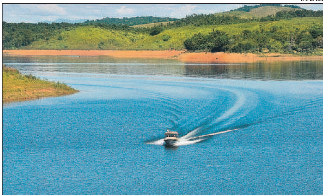
Represa do Jaguari, uma das que compõem o Sistema Cantareira: recuperação antes do período de estiagem
