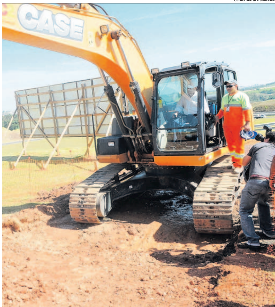
Governador Geraldo Alckmin opera máquina durante lançamento das obras de prolongamento do anel viário
